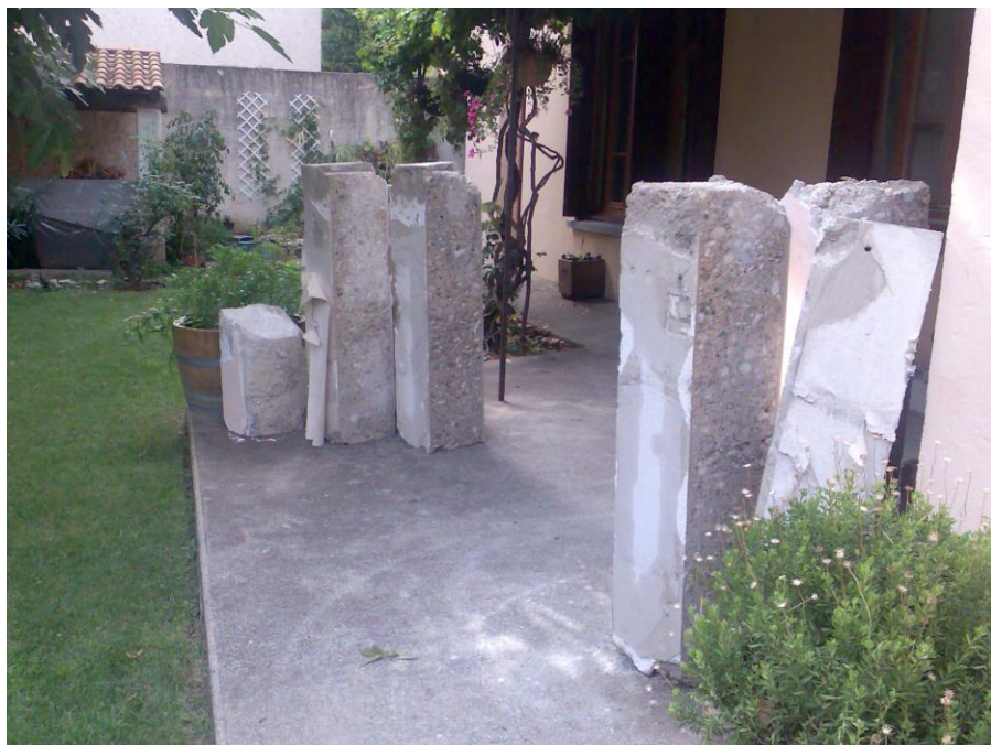
les blocs découpés prêts à être évacués
