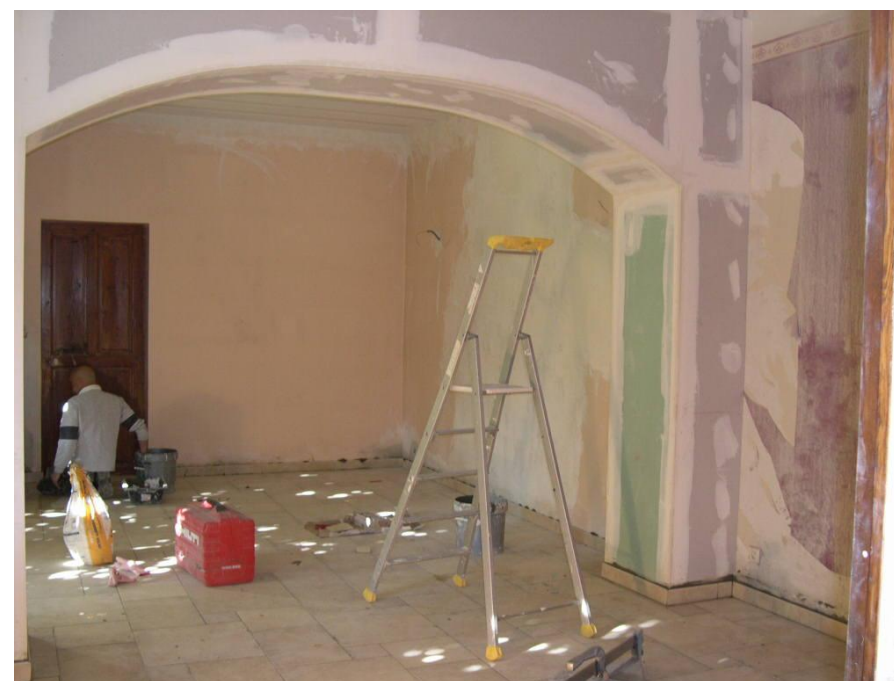
habillage en plaque de plâtre avec cintre
