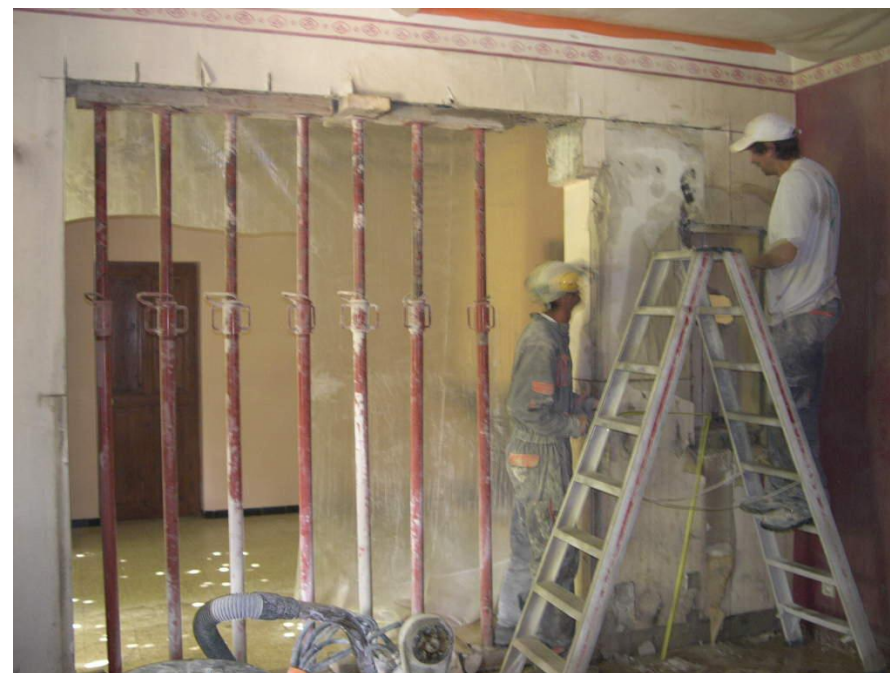
le mur de refend est sérieusement étayé
