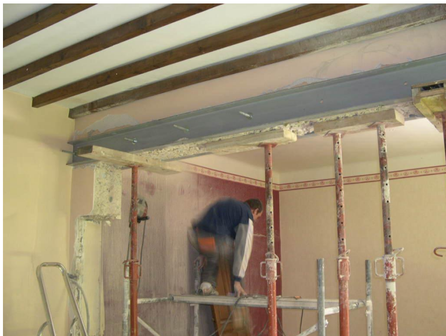
2 poutres IPN jumelées soutiennent le mur de refend
